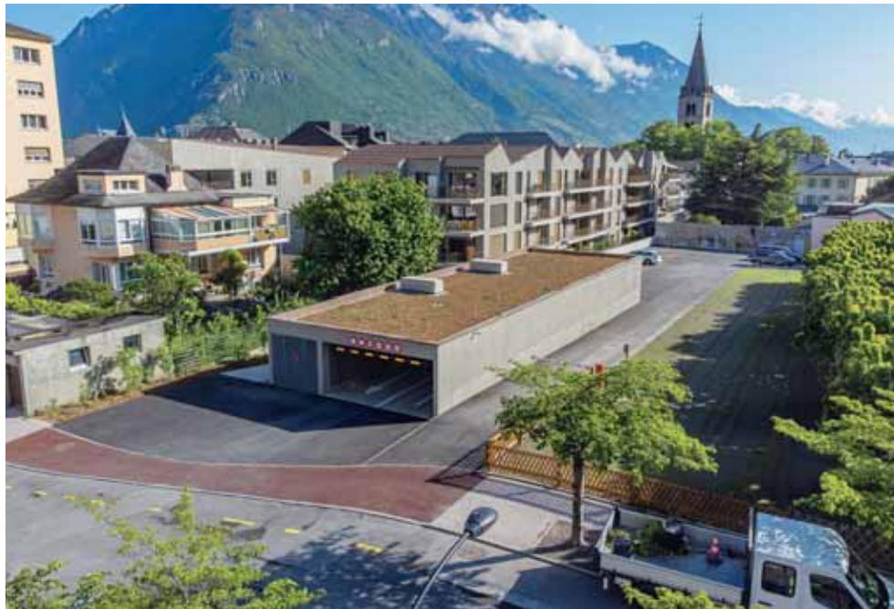
L'accès au parking de 120 places se fait par la rue des Morasses. LDD
