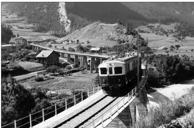
Une automotrice sur le viaduc de Sembrancher (années 1950). On peut voir la gare sur le côté gauche de l'image. FONDS KÜNZI, COMMUNE D'ORSIÈRES, MÉDIATHÈQUES VALAIS - MARTIGNY
