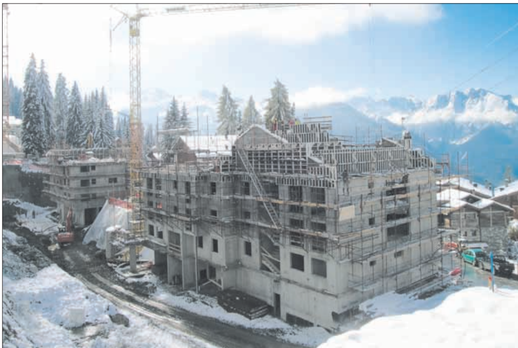
Le projet Les Trois Rocs à Verbier a débuté en avril dernier. Aujourd'hui les premières constructions sont visibles. Le chantier avance normalement et le complexe ouvrira ses portes en décembre 2013.
