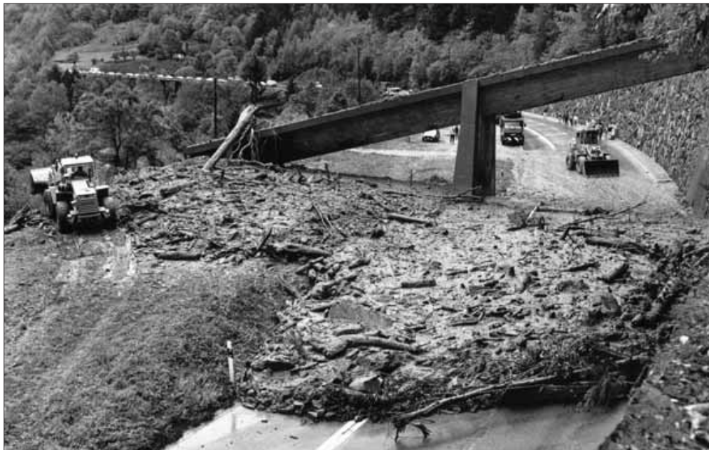
Les éboulements de 1988 à Martigny. ROBERT HOFER
