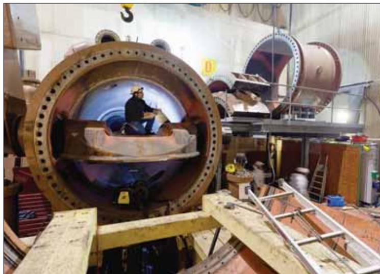
*Réglage du robot de décapage et de peinture des puits blindés.* ROBERT HOFER
