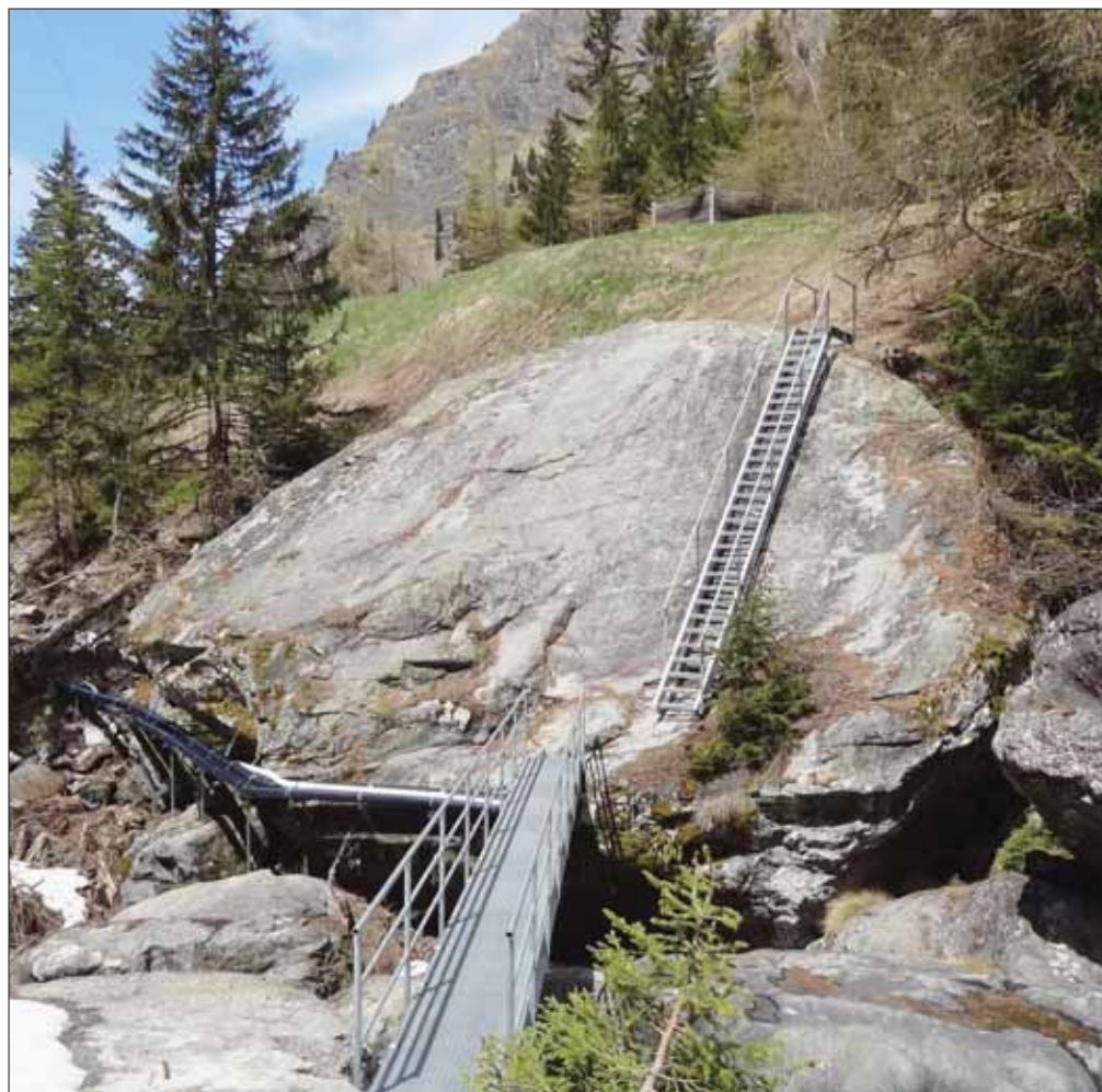
Une nouvelle installation qui offre l'occasion de fournir de l'eau potable et de l'énergie. LDD
