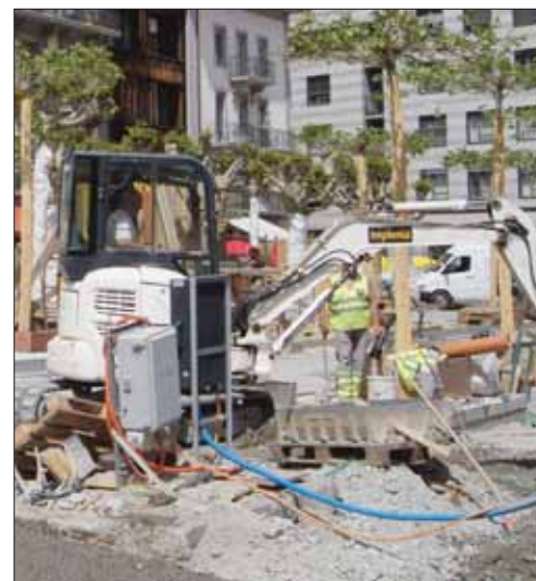
La place en plein travaux. PAULETTE LESAGE
