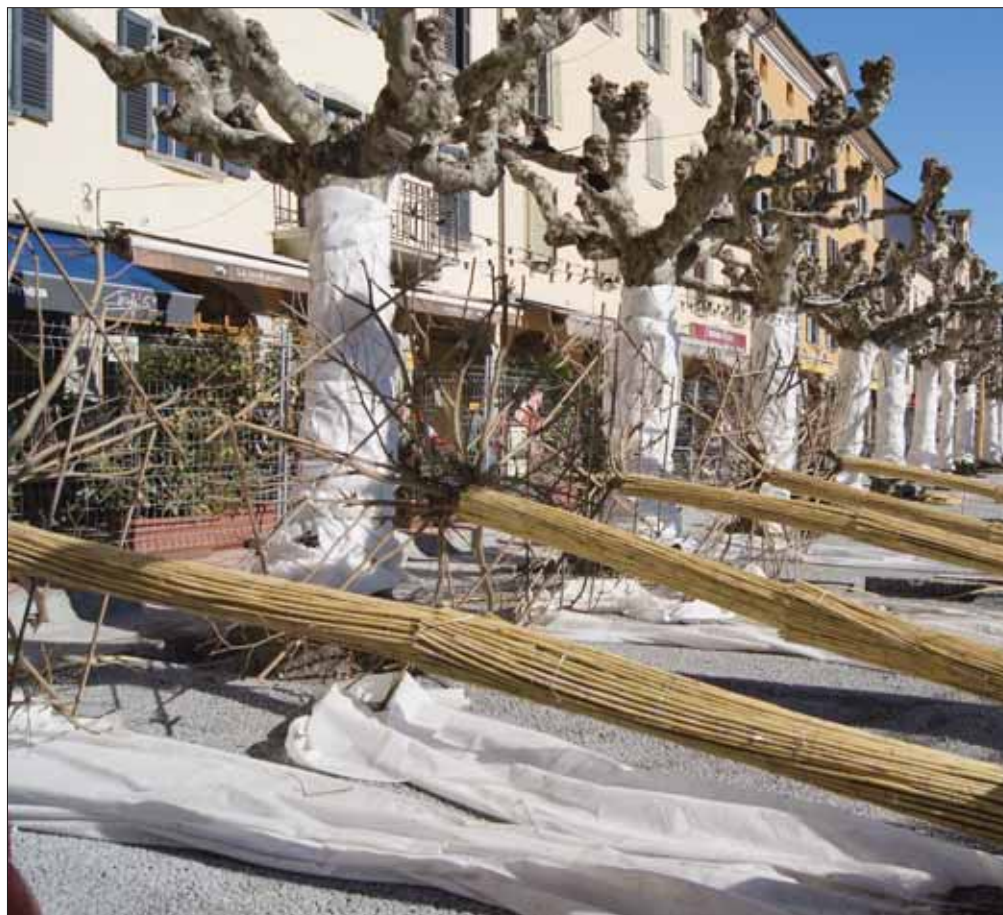
Des platanes protégés durant les travaux pour éviter de les endommager. PAULETTE LESAGE
