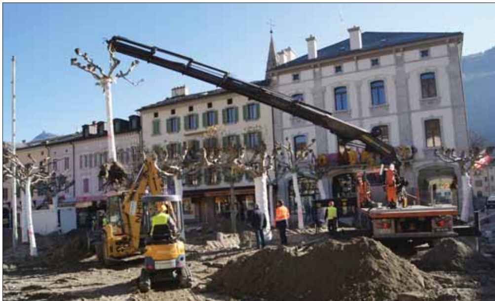
(Suite en page 24) La place Centrale en pleins travaux. Souvenirs, souvenirs... PAULETTE LESAGE
