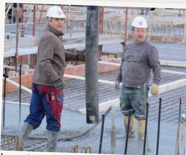
Les ouvriers guident le tuyau amenant le béton et vibrent la masse pour l'égaliser et bien enfermer la ferraille. MAG
