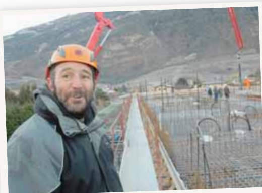
Steve Tala aux commandes de la pompe à béton. MAG
