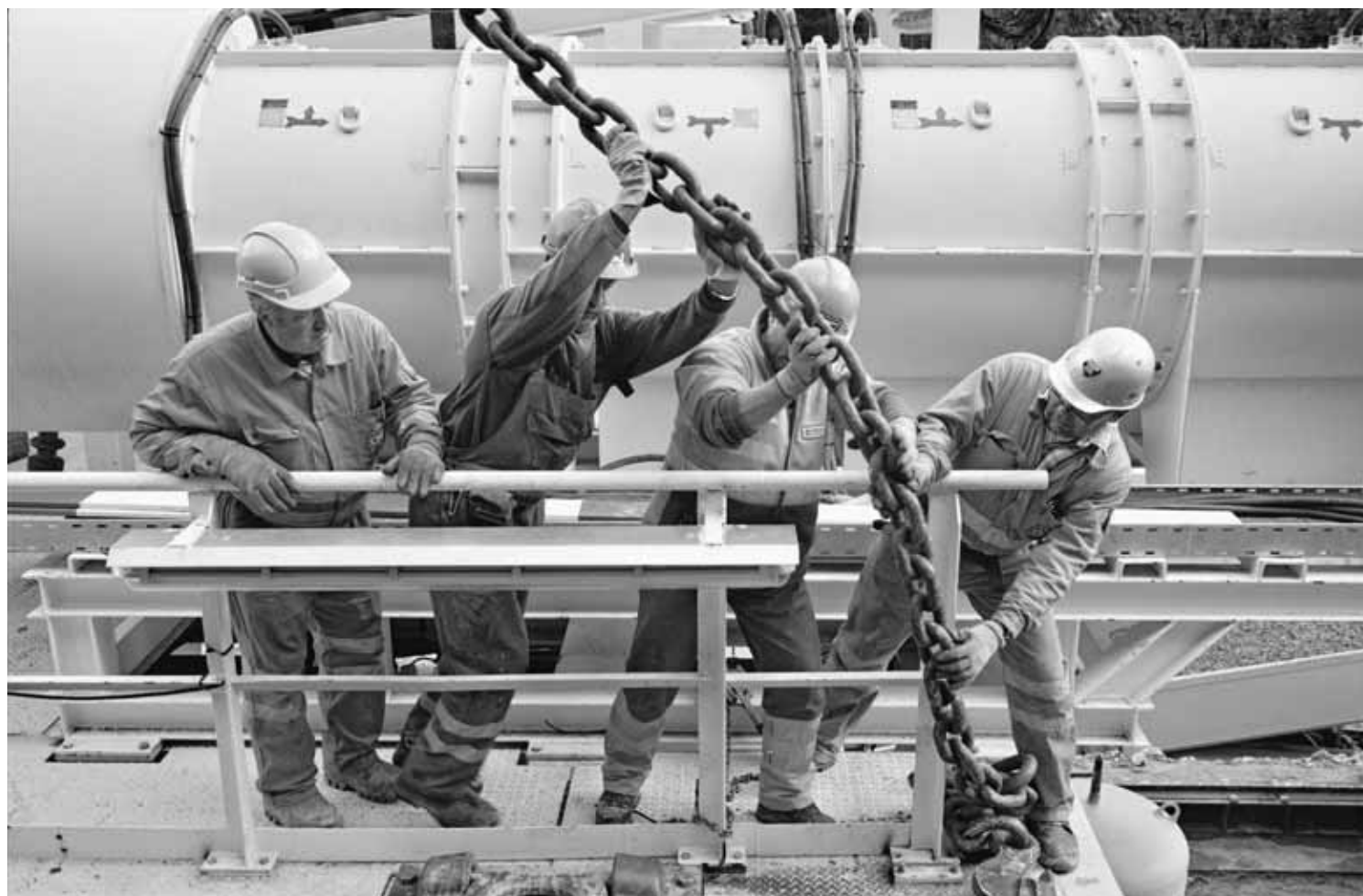
Finhaut, Châtelard, montage des éléments du tunnelier, 2009. BERNARD DUBUIS
