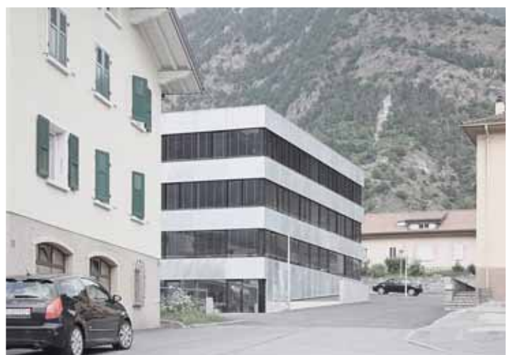
ALIGNEMENT. Une construction qui se marie avec les autres bâtiments existants. R2A ARCHITECTES
