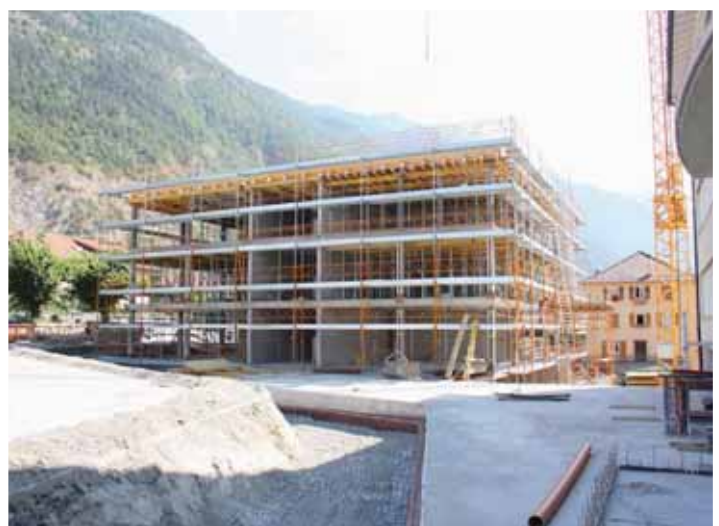
LES TRAVAUX ont débuté en avril 2015 et les élèves sont rentrés cette année déjà dans la nouvelle école. LDD
