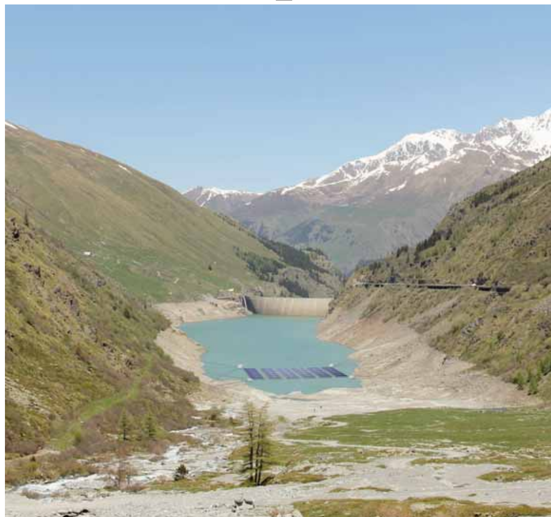
Le projet: une structure pilote consistant en un tapis de 36 flotteurs accueillant 2240 mètres carrés de panneaux solaires. Les flotteurs pourront s'élever et s'abaisser en même temps que le niveau d'eau.
