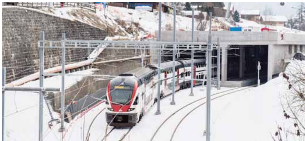
La nouvelle entrée de la gare du Châble qui peut désormais accueillir les trains à deux étages. HÉLOÏSE MARET
