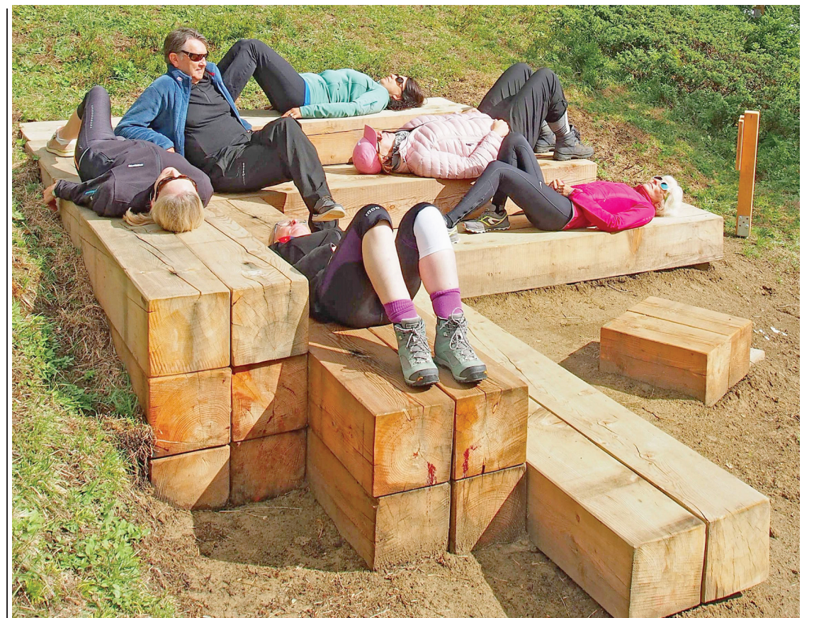
Le sauna solaire s'inspire de l'architecture d'un véritable sauna. Entièrement en bois, il est composé de banquettes en angle droit sur trois niveaux. Il est orienté plein sud pour profiter au maximum du rayonnement solaire. LDD
