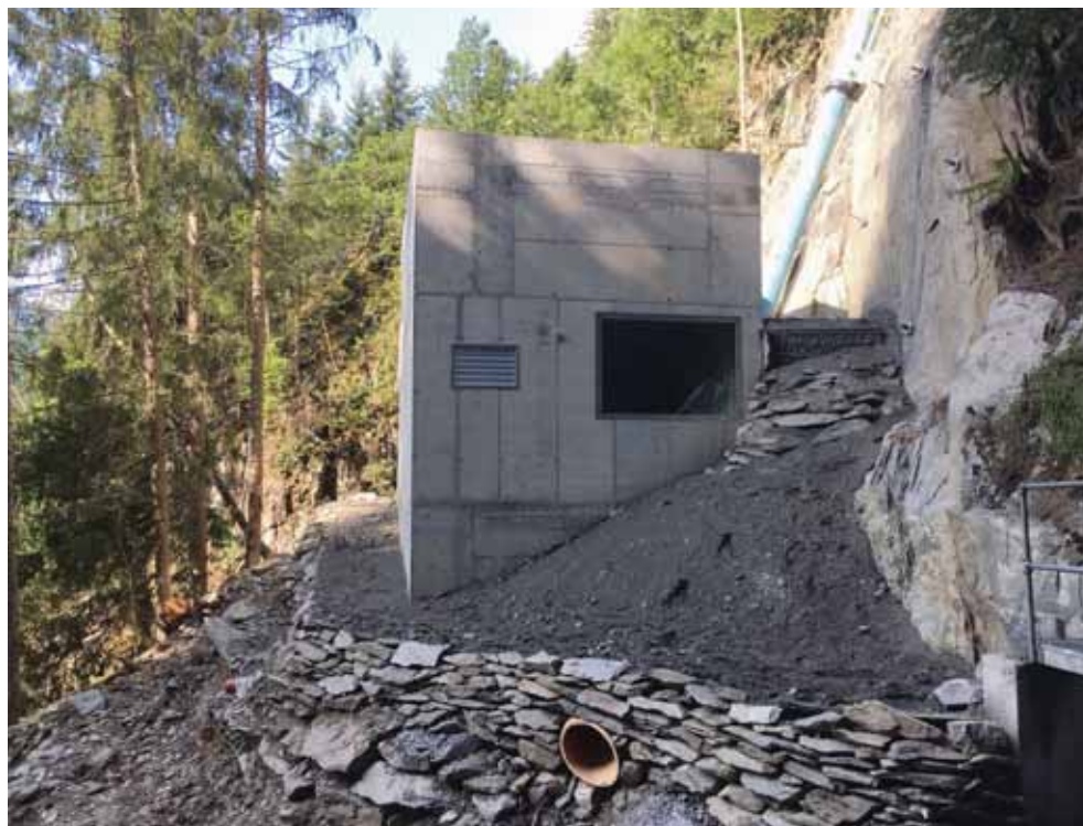
Après un peu plus d'une année de travaux, le nouvel aménagement hydroélectrique de Finhaut a été mis en service. LDD
