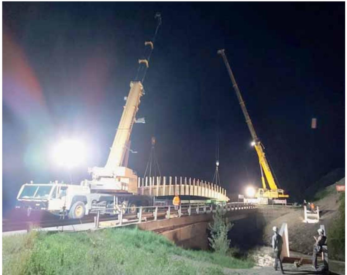
UNE PASSERELLE DE 40 MÈTRES ET 20 TONNES
