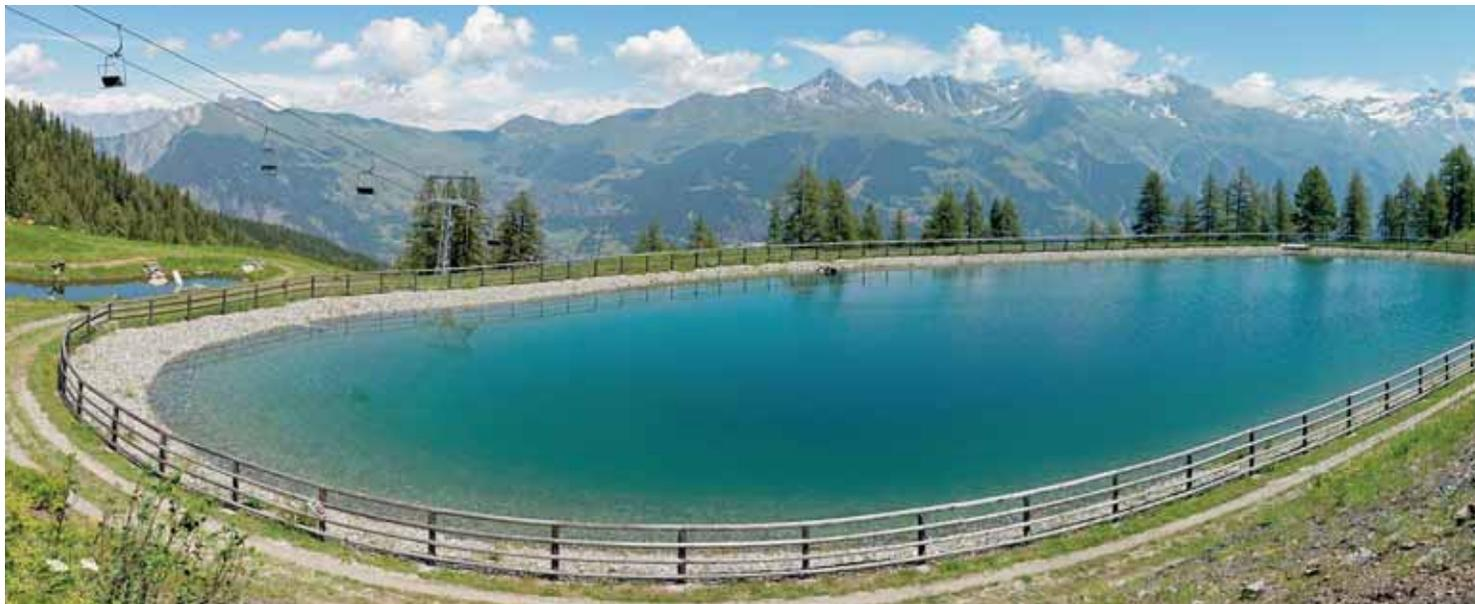
La retenue multiusage de Moneyeu sur les hauts des Mayens de Bruson, pour l'enneigement et la défense incendie et, demain, l'irrigation ainsi que le stockage et déstockage d'énergie électrique. LDD
