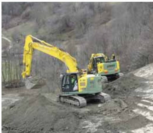
Les machines tournent à plein régime pour sécuriser la zone. OLIVIER RAUSIS
