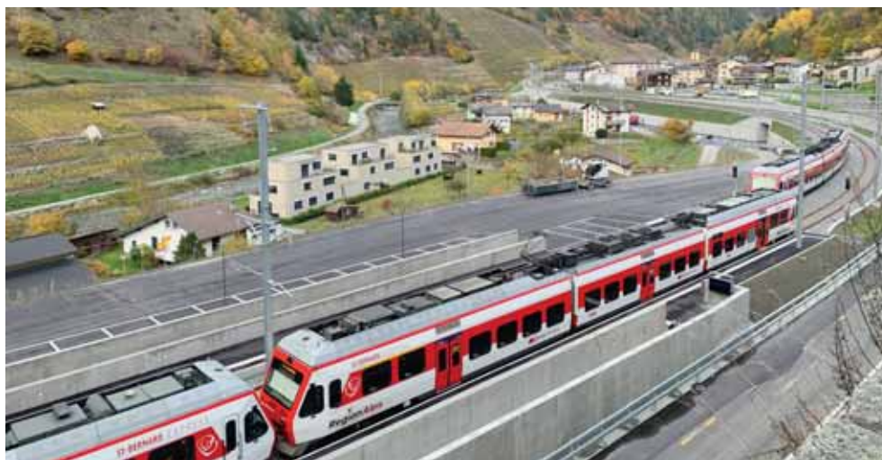
Quelque 10 millions de francs ont été investis pour rénover la gare de Bovernier. TMR
