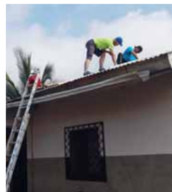
Installation des panneaux solaires à la Mission. LDD
