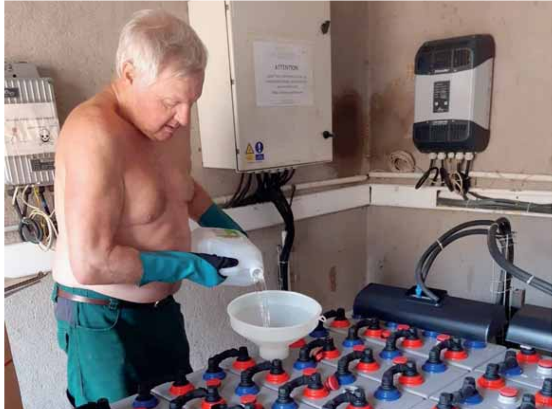
Jérôme Valloton participe activement à la maintenance des installations électriques de l'association Galagala au Cameroun. LDD
